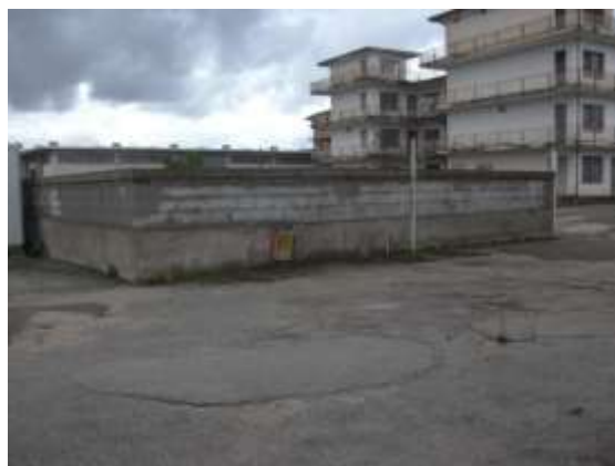
Foto n. 10: cassetta attacco idrante
